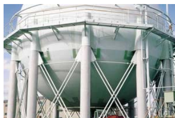
<球形タンク脚柱耐火モルタル被覆>
