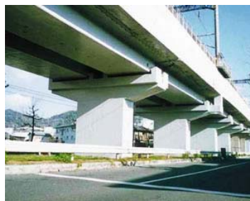
<高架橋橋脚の補修>
