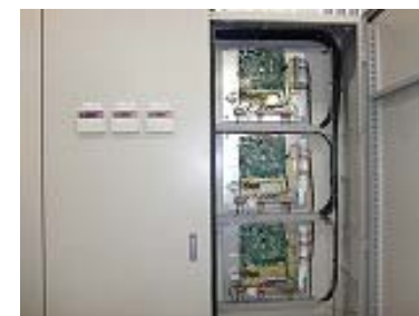
<冷設・防熱工事>
