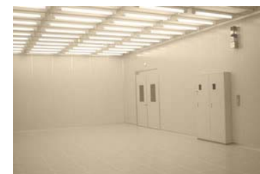
<クリーンルーム>
