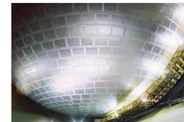
<LNGタンク防熱(パネル工法)>
