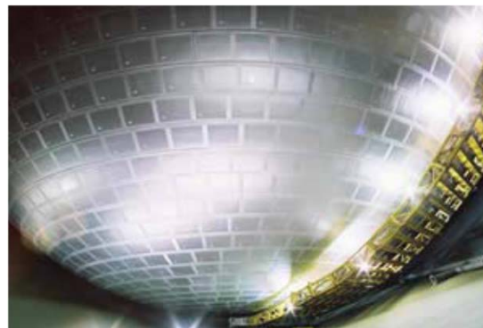
<LNGタンク防熱(パネル工法)>
