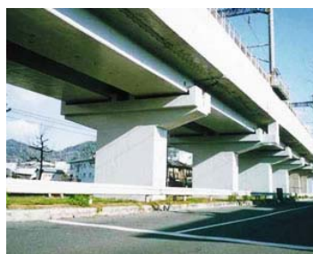
<高架橋橋脚の補修>
