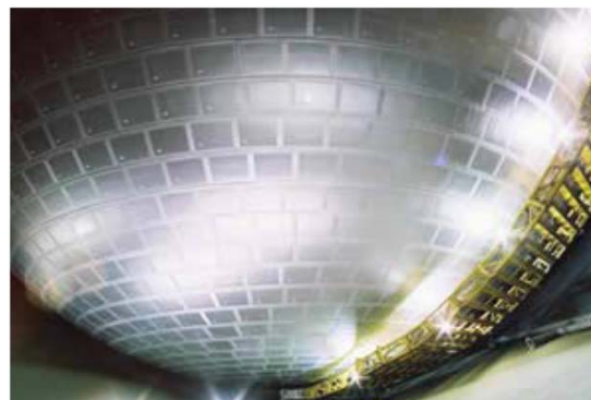
<LNGタンク防熱(パネル工法)>
