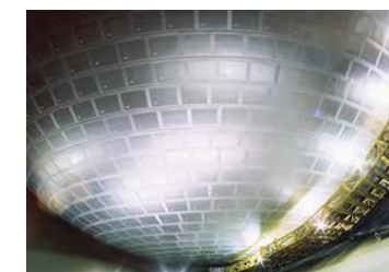
<LNGタンク防熱(パネル工法)>
