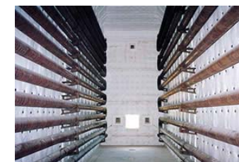
<加熱炉内セラミックファイバー施工>
