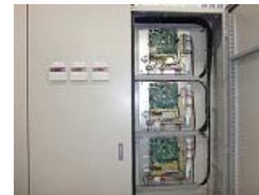
<冷設・防熱工事>
