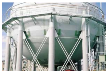
<球形タンク脚柱耐火モルタル被覆>
