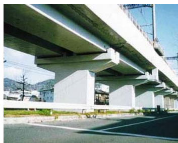
<高架橋橋脚の補修>
