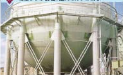
適用例 5 球形タンク脚柱、耐火モルタル防水
